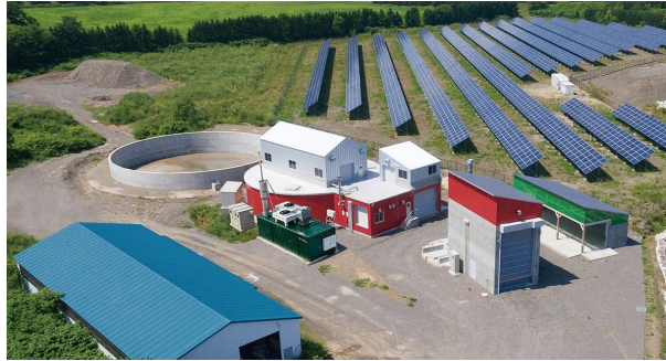
バイオガスプラント
