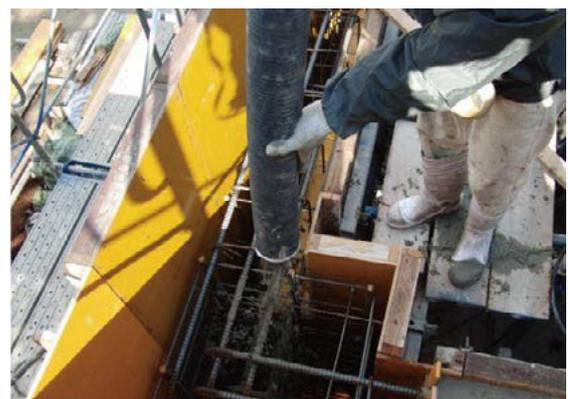
写真6 生コンの吐出状況(吊打ち)
