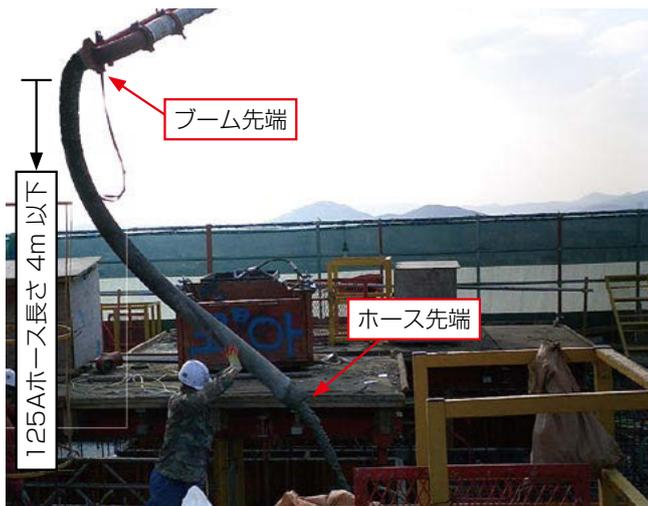
写真3 吊打ち(韓国での事例)
