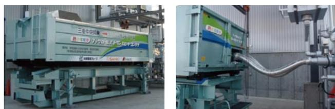
写真2 トランスヒートコンテナと熱交換器接続状況
