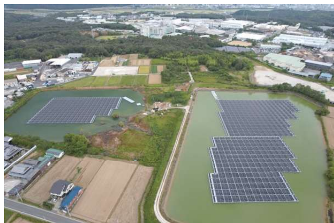
ため池ソーラー全景
