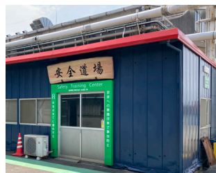
名古屋工場安全道場外観
