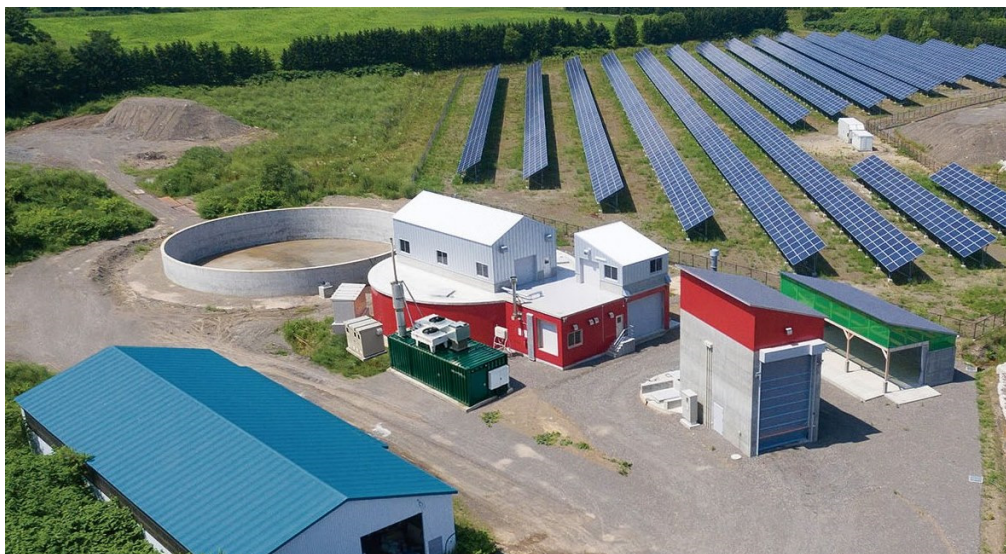
興部北興バイオガスプラント
