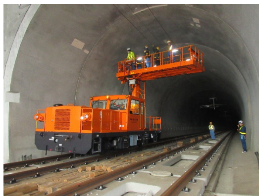
新幹線向け架線作業車
