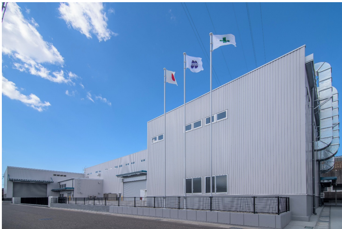
北陸重機工業株式会社 本社 新第一工場
