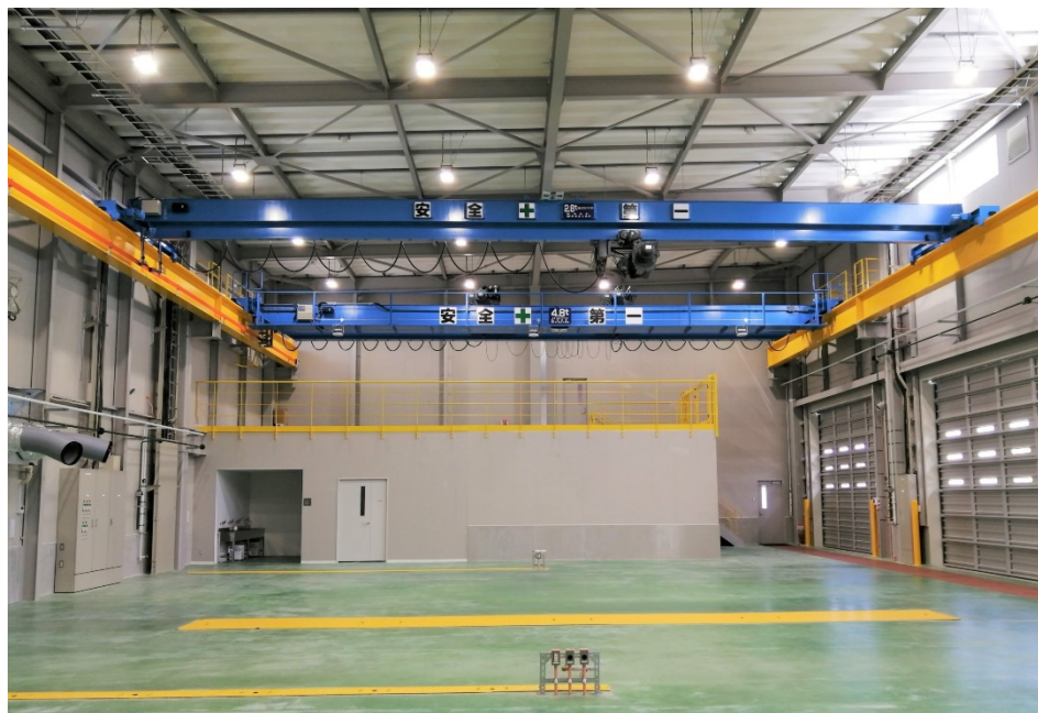
センター内 整備ブース
