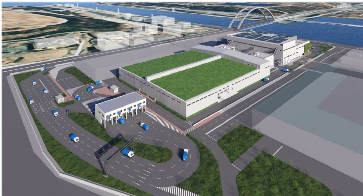
新中防 不燃・粗大ごみ処理施設整備工事 (2027年度竣工予定)
