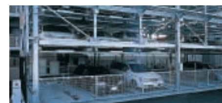
立体駐車装置
