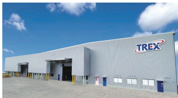
日本トレクス 本社 トレーラ生産工場
