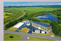
西天北サーマルリサイクルファクトリー (2021年)
