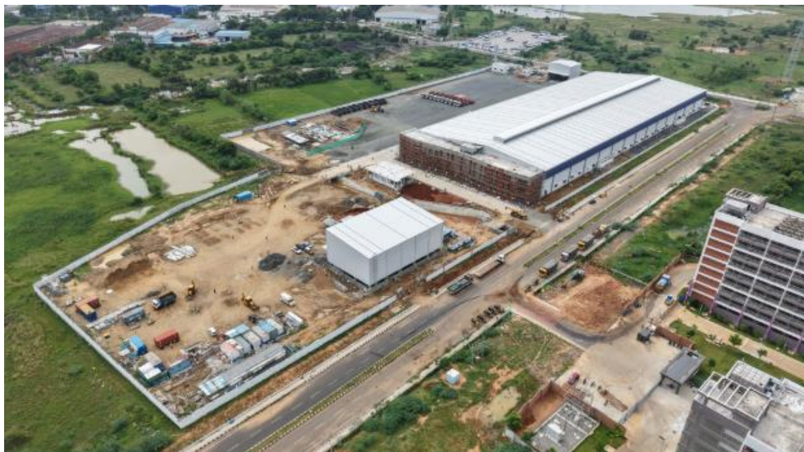
チェンナイ工場全景(建設中)
