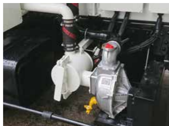
ポンプ吸入側ストレーナ
